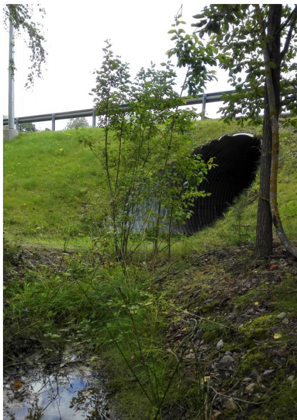
Kuva 3.5. Lepolassa Poikkittien ali on rakennettu alikulku-tunneli, joka mahdollistaa eläinten ja ihmisten liikkumisen.
